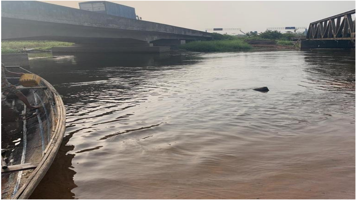
Plate 3.2: Station 2 lies between latitude N 06° 03. 127° and longitude E 005° 39. 835°
